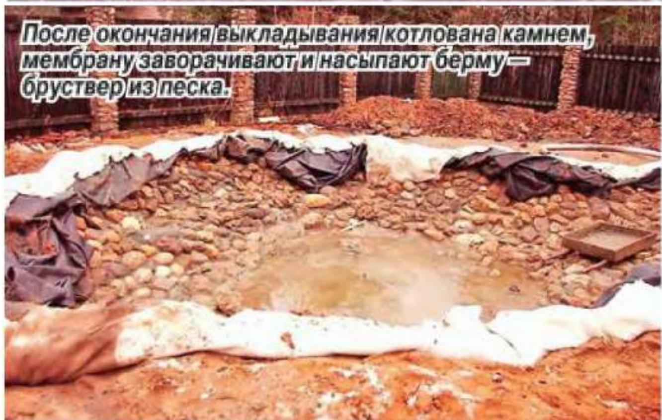
**После окончания выкладывания/котлована камнем, мембрану заворачивают и насыпают берму — бруствер из песка.**
