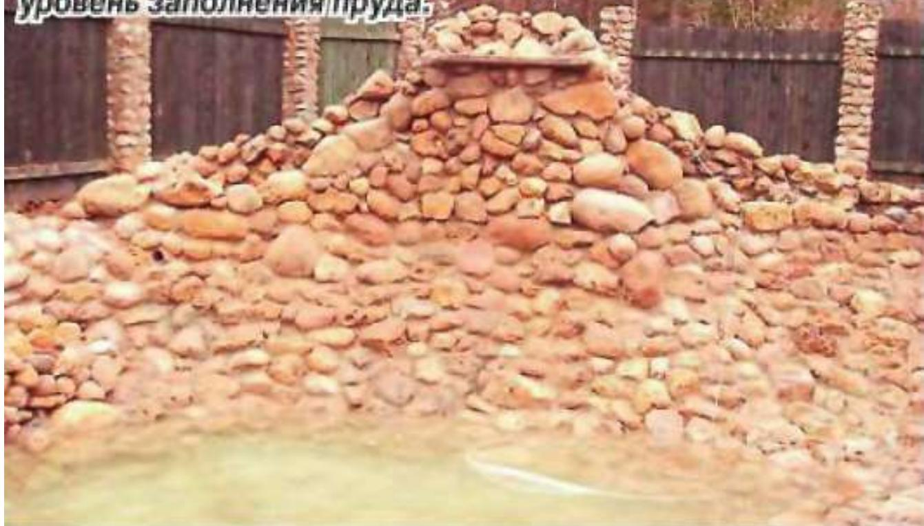
Первая вода выкачана, дно пруда почищено, появившиеся щели между камнями заделаны. Установлен насос, шланг и провод спрятаны в закладную трубу. В лакуны высажены растения. Пруд начинают заполнять водой. Проба работы насоса на малой воде.
