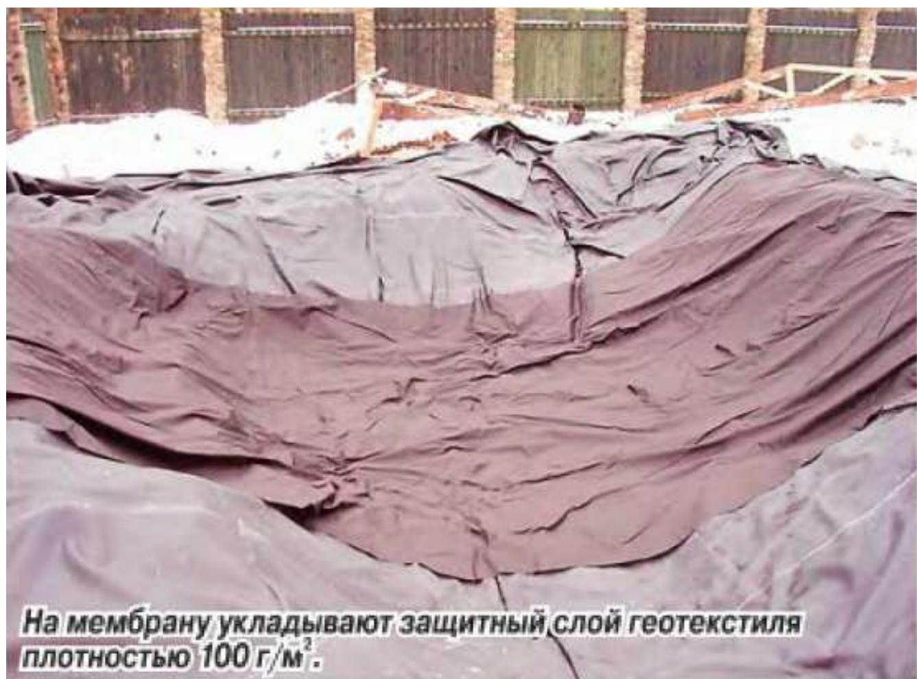
На мембрану укладывают защитный слой геотекстиля плотностью 100 г/м<sup>2</sup>.
