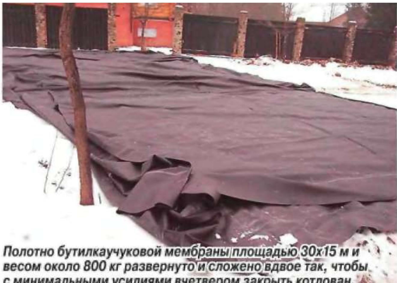
**Полотно бутилкаучуковой мембранный площадью 30x15 м и весом около 800 кг развернуто и сложено вдвое так, чтобы с минимальными усилиями вчетвером закрыть котлован.**
